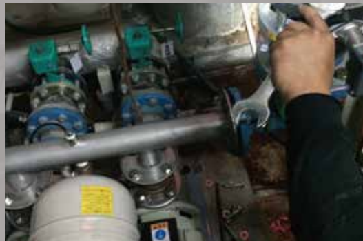
ボイラーのメンテナンス
