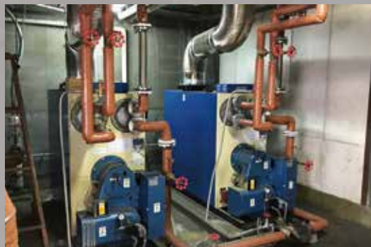
ボイラーの新設・設置
